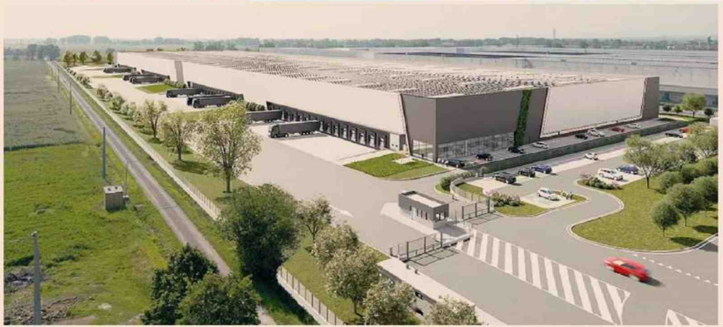
Il render. Il progetto del Fidenza Logistics Park, in corso di costruzione nell'area di Parma
