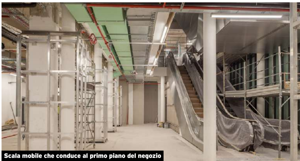
Adeguamento degli impianti
