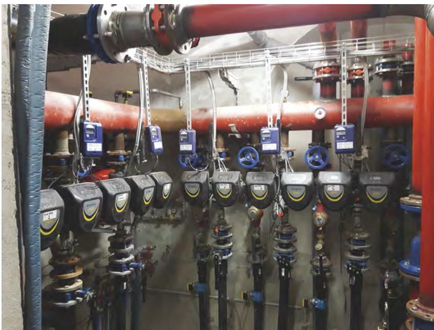
L'adeguamento delle portate alle esigenze effettive delle unità in pompa di calore è demandato alla programmazione degli inverter delle elettropompe a velocità variabile (Climosfera Srl).
